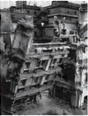
難工事の連続となった旧1号館解体の様子。石造りの壁が倒され、更地に戻された下には、最大の難所と呼ばれた金庫室の存在があった。その撤去には、船舶解体の技法を用いるしかなかった。
